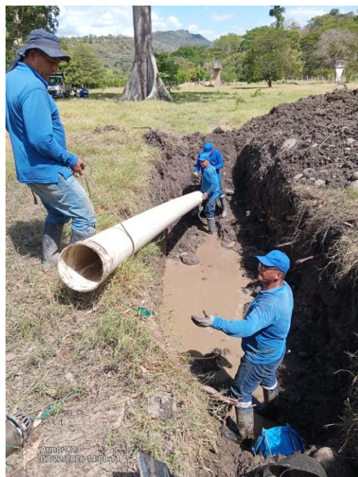
Registro de las labores de reparación de la falla presentada el 21 de julio y atendida el 22 de julio. Reemplazo de tramo de 6m por tubería PVC RDE 26 UM de 10"
