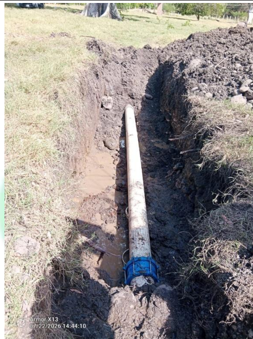
Registro evidente del alto deterioro de la tubería por cristalización del material PVC.
